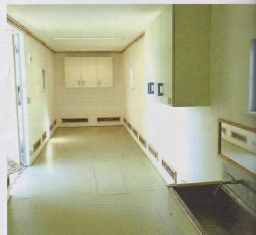
Fast fertig: der Container in der Umbauphase.
